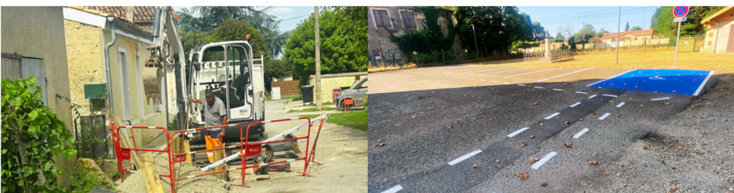
TRAVAUX DE VOIRIE ET PARKING ECOLE
